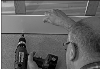
Erstes Steck-Paneel befestigen
