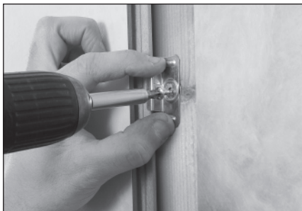
Mittelklammer setzen
