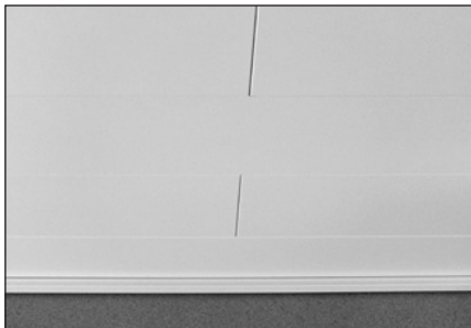
Deckenabschlussleisten aufstecken – fertig
