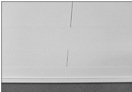
Deckenabschlussleisten aufstecken – fertig
