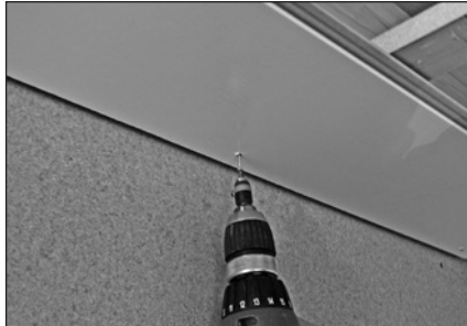
Erstes Steck-Paneel befestigen
