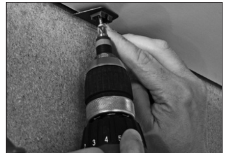
Leistenclip montieren
