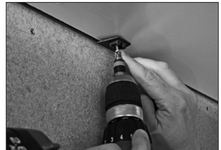
Leistenclip montieren
