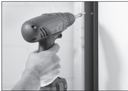
Befestigungsschiene setzen
