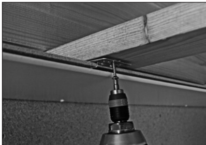
Befestigungskralle anschrauben
