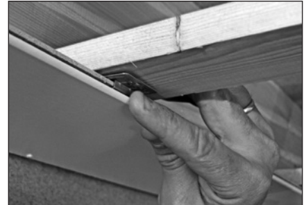
Befestigungskralle setzen
