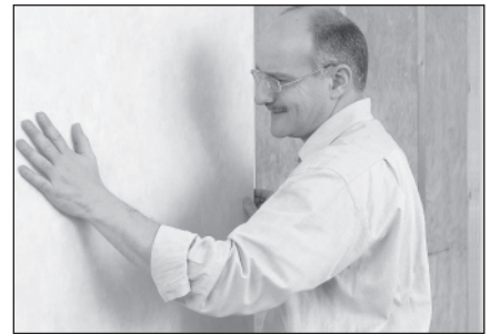
Einsetzen erste Platte
