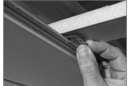
Befestigungskralle setzen
