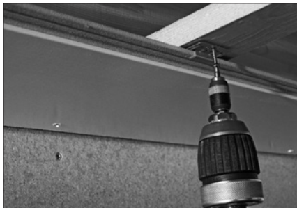
Befestigungskralle anschrauben
