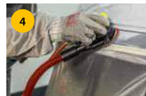
4 Vorbereitung für Lackauftrag Abralon K 2000
