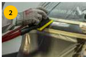
2 Spachtel ebnen und Übergänge schleifen OSP-3, OSP-4
