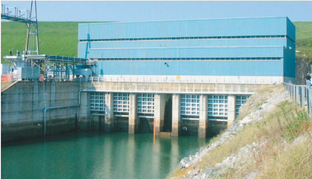
Das mit TELEPERM® XS geregelte Wasserkraftwerk Keowee dient zur Notstromerzeugung für das Kernkraftwerk Oconee
