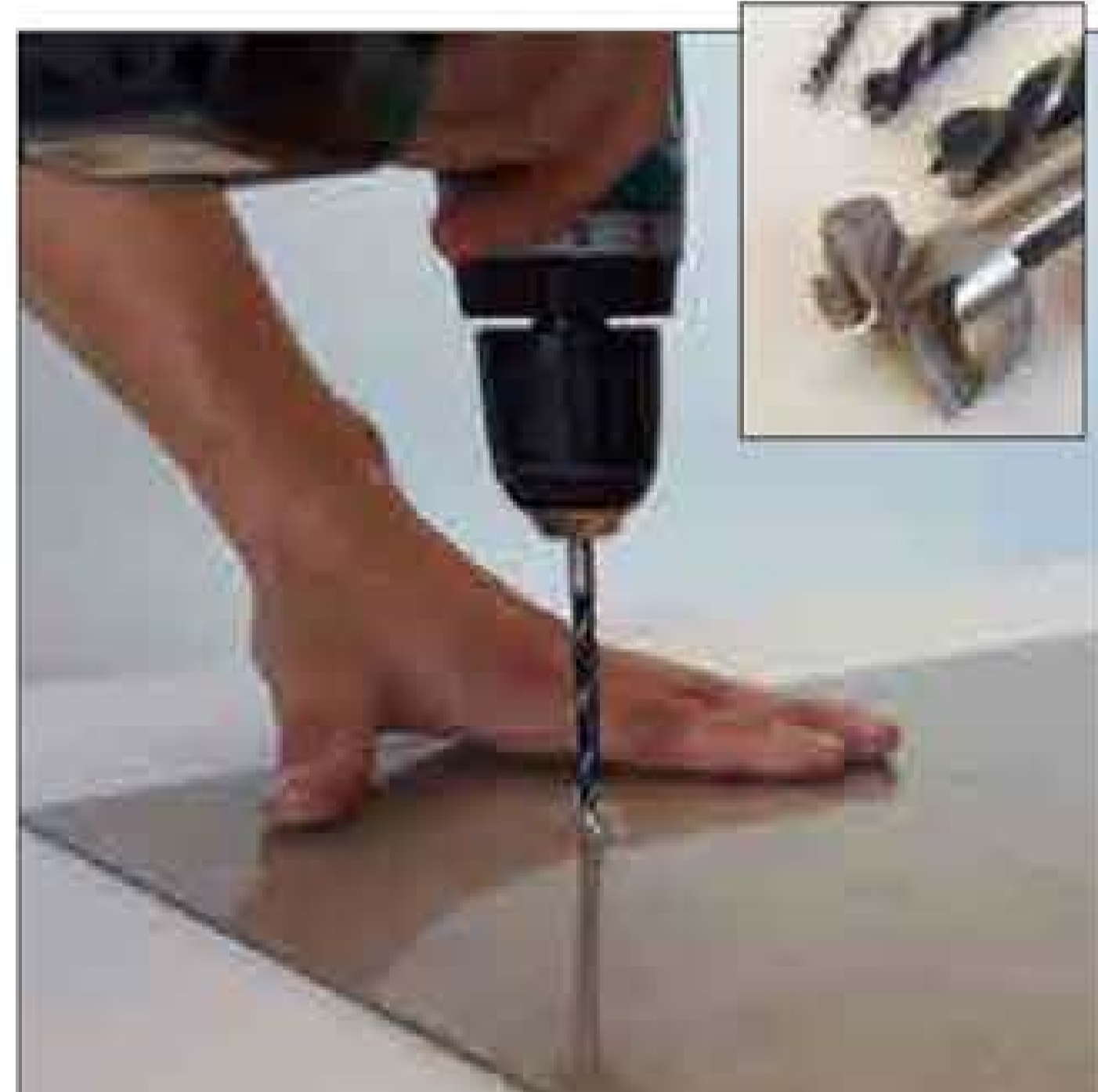
Bohrung Eckfreistellung mittels Holzbohrer mit Zentrierspitze
