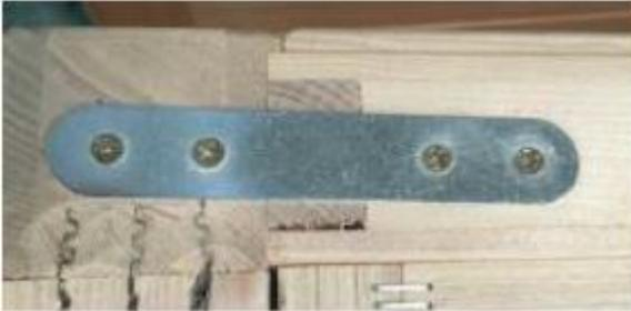
Verwenden Sie einen Metallbügel (D), um die Oberseite der Frontseite und der Seitenwand fest miteinander zu verschrauben (mit Schrauben C).
